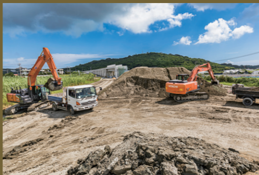
現場風景。中央に盛られた土はほかの工区の残土が仮置きされたもの。土質改良後に当地の盛土にも使われる。
