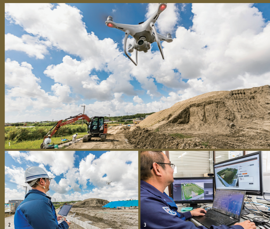
1. ドローンは現場を上空から撮影するために以前より保有していたが、空中写真測量に活用するのはこの現場が初めて。悪天候でなければいつでも現場の現状把握ができるようになった。2,3. ドローンの操作からクラウドへのデータアップロード、3次元設計データの利活用まで、具志堅氏自身が行っている。
