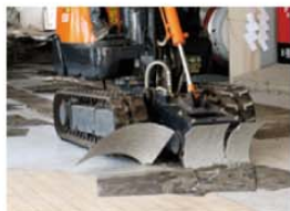
床材はつり機作業
