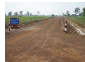
ラテライト舗装された村道
