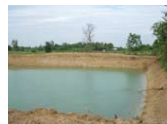
完成したため池
