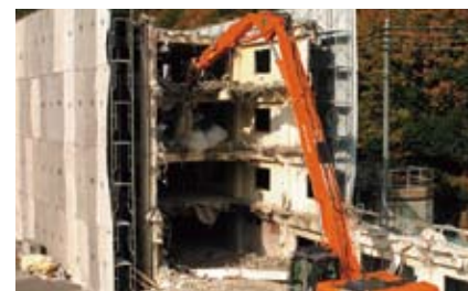
解体向け専用機
