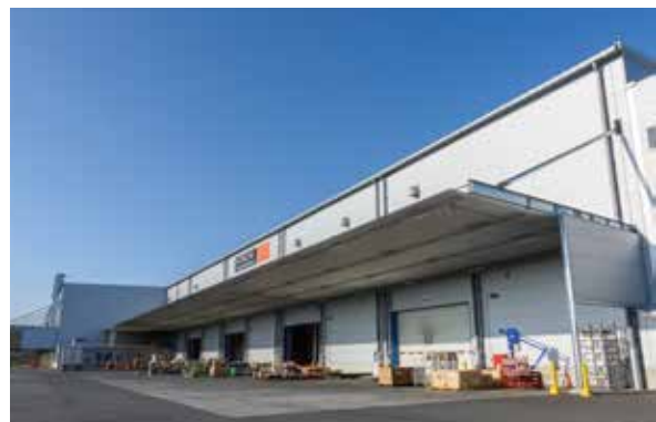
「つくば部品センタ」外観
