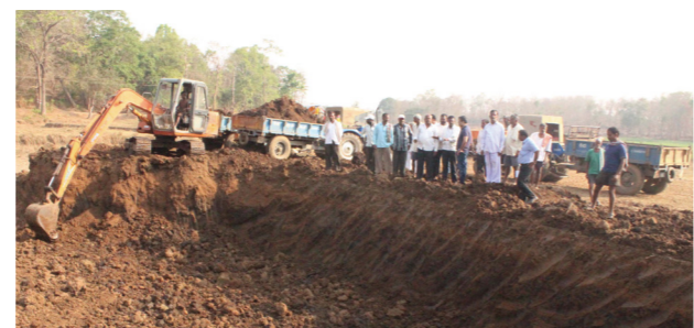
タタ日立社による浚渫工事の様子
