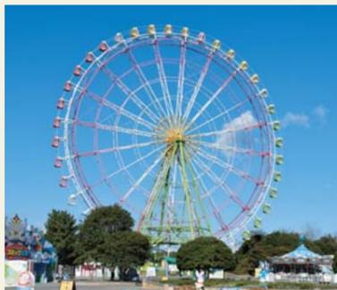
油圧を動作に変える「油圧アクチュエータ」。遊園地にあるお馴染みの観覧車は、油圧の力を回転に変える油圧モーターがアクチュエータとして使われている。いくつものゴンドラを支える巨大なホイールを複数の油圧モーターでサンドイッチし、ゆっくり回転させることによって観覧車は動いている。ゆっくりと正確に回り、大きな力を出せるのは油圧の得意なところ。安定性や制御のしやすさ、静音性、さらにはコンパクトでコストが抑えられるといった油圧モーターの優位な性能面から、多くの観覧車に油圧モーターが採用されている。
