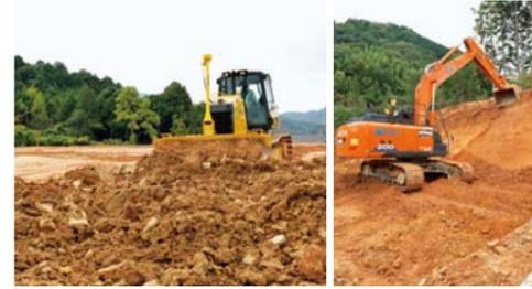
日立建機日本からレンタル提供しているICT油圧ショベルZX200X-6とブルドーザ。上:盛土工事の法面整形。カーブのきつい曲線道路のため従来施工だと必要な丁張が少なく済み、作業効率や安全性も向上する。下左:1層30cmごとに盛土された面を整地していくICT施工対応のブルドーザ。積層ごとのオフセット値や水勾配のデータ補正を加えながら作業していく。下右:切土施工の現場でもICT油圧ショベルに組み込んだ三次元設計データにより、高い精度で施工を実現。
